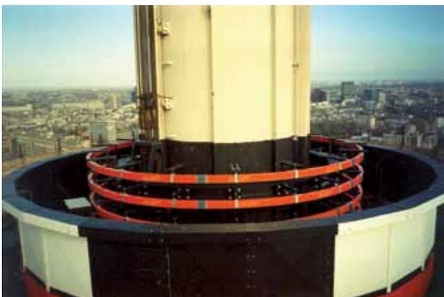
*4 замкнутых изогнутых токопровода для вращающегося лифта*
